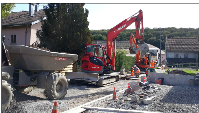
Rue des grands champs en chantier.
