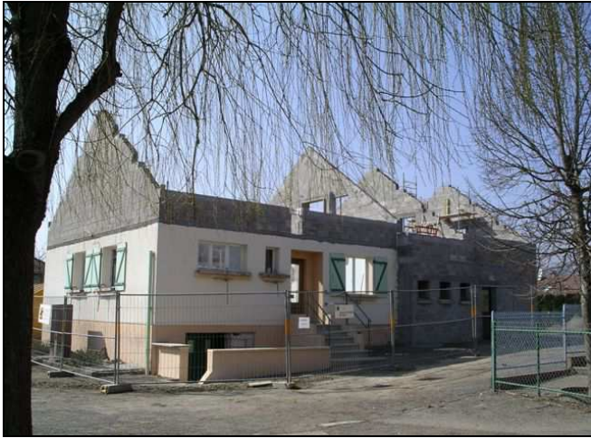
Mars 2004, la nouvelle mairie pousse sur l'ancienne (murs blancs).
