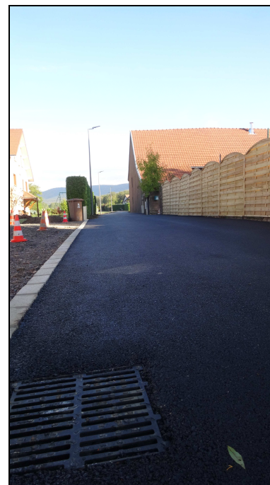
Après le chantier.
